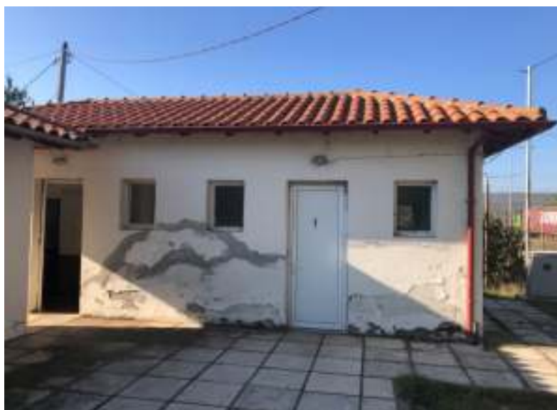
Φωτογραφία 1. Κτήριο τουαλετών κοινού (όψη)
