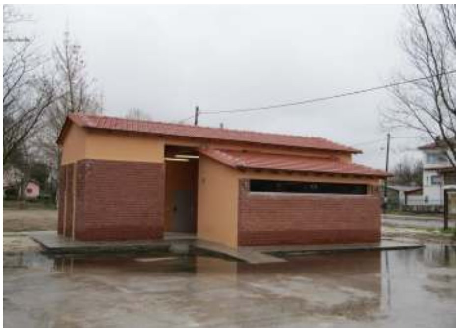
Φωτογραφία 3. Θέση κατασκευής φρετίων υδροσυλλογής
