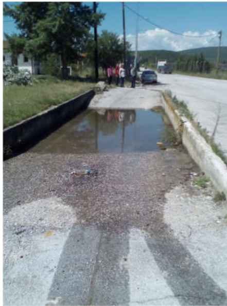
Φωτογραφία 1. Το απολυμαντήριο στη δεξιά λωρίδα κυκλοφορίας του ρεύματος εισόδου.
