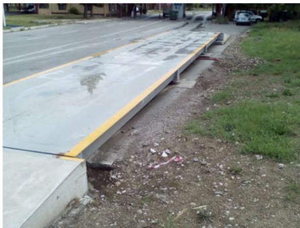
Φωτογραφία 2. Η γεφυροπλάστιγγα στη δεξιά λωρίδα κυκλοφορίας του ρεύματος εισόδου.
