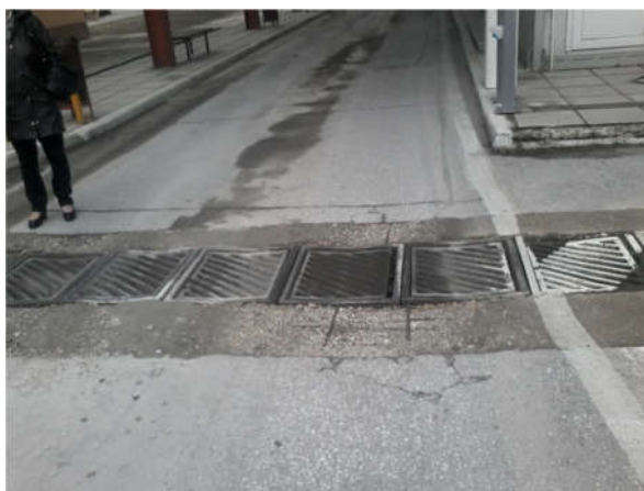
Φωτογραφία 3. Τα σχαρωτά φρεάτια υδροσυλλογής όμβριων υδάτων.
