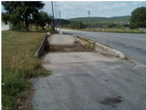
Φωτογραφία 4. Το απολυμαντήριο στη δεξιά λωρίδα κυκλοφορίας του ρεύματος εισόδου.
