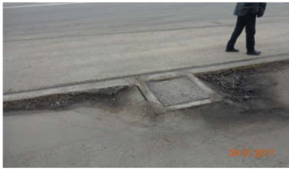
Φωτογραφία 6. Φθορές οδοστρώματος.
