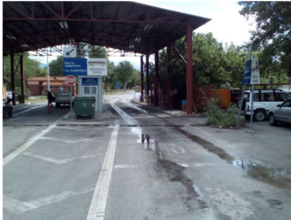
Φωτογραφία 7. Φθορές οδοστρώματος.
